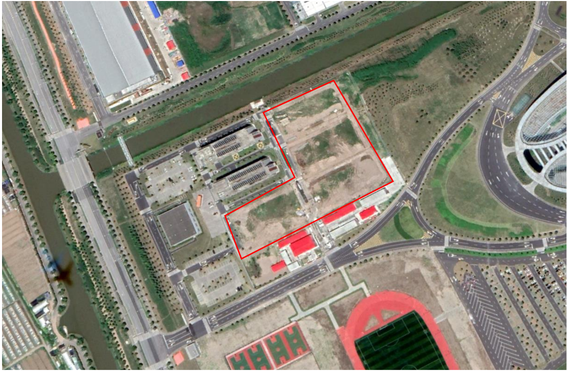
图1.6-1 建设前卫星影像(2018年7月)
