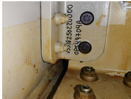
▼ 空客 350 飞机机体内部排液通道
