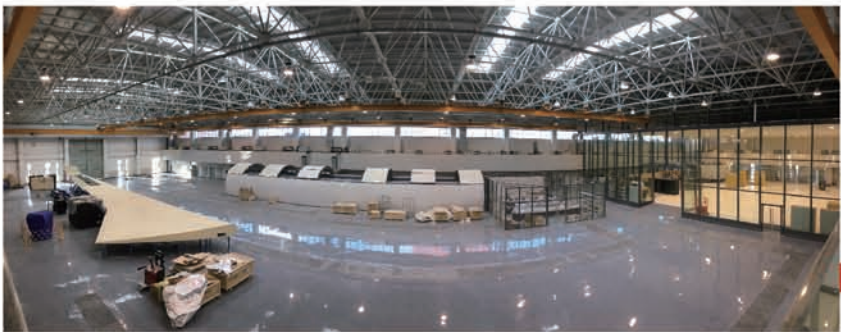
2.北研中心多电航电实验室完成政府竣工验收
